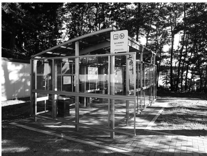
ボイラー室裏喫煙コーナー
